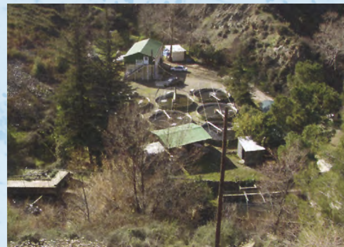
Ερευνητικός Σταθμός Υδατοκαλλιέργειας Γλυκών Υδάτων στον Καλοπαναγιώτη
